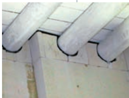
Coibentazione attorno alle travi con particolare delle nastre con bandella auto espandente di sigillatura
