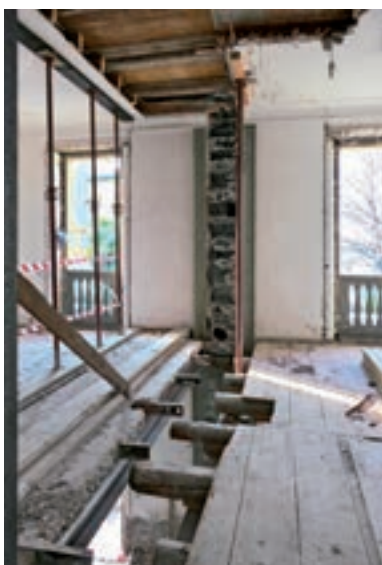
Consolidamento dei solai tramite l'inserimento di pioli in acciaio uniti tra loro da travetti e reti elettrosaldate
