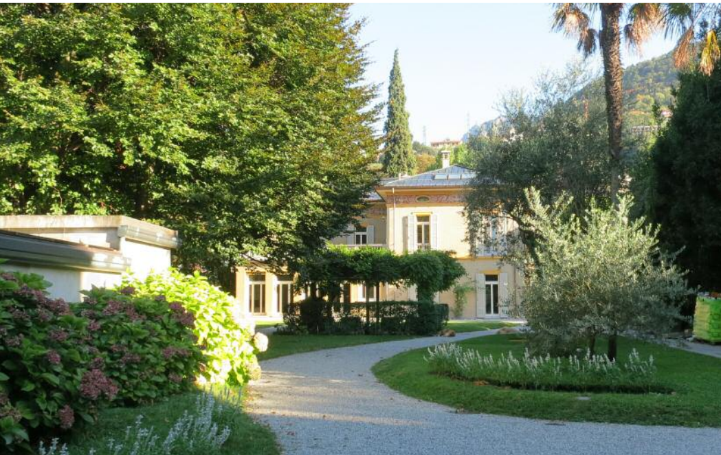
A sinistra, vista prospetto frontale dal giardino.
